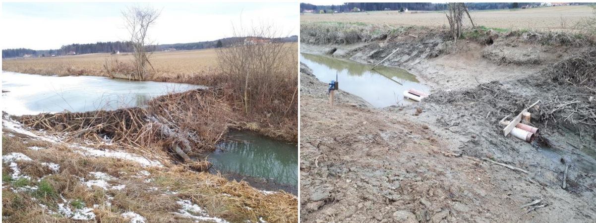
Abb. 7: Hauptdamm des Biberreviers an der Lahn bei Ruppersdorf vor dem Eingriff (links) und nach erfolgter Absenkung und Einbau einer Dammdrainage (rechts).
